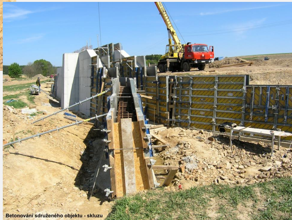
Betonování sdrúženého objektu - skluzu
