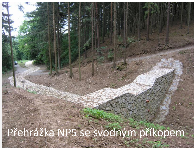
Polopropustná přehrážka z gambionů
