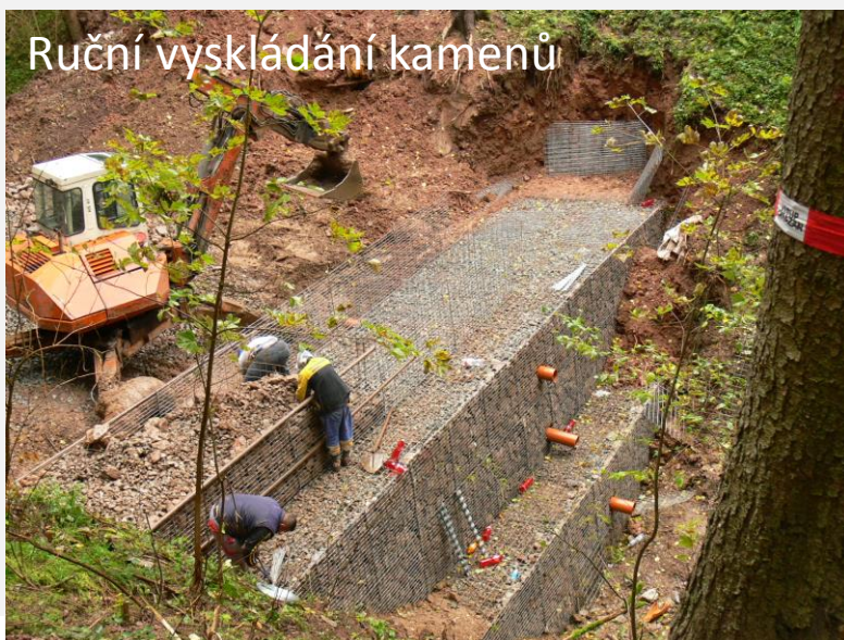
Polopropustná přehrážka z gambionů
