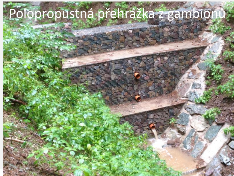
Přehrážka NP5 se svodným příkopem
